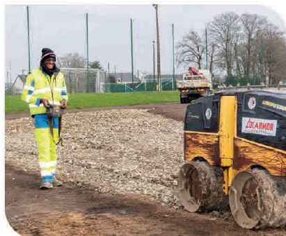
Janvier. Les travaux du City Park débutent au terrain des sports.
