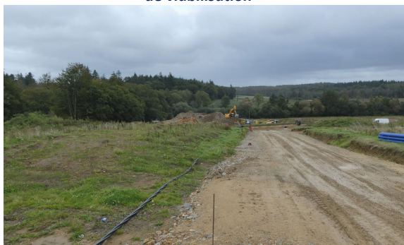
Vue vers le Sud depuis le haut du lotissement en cours de viabilisation
